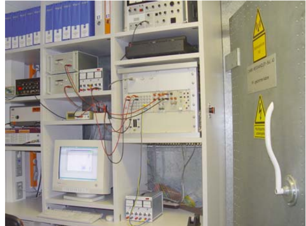
Geschirmte Kabine mit Kontrollplatz
